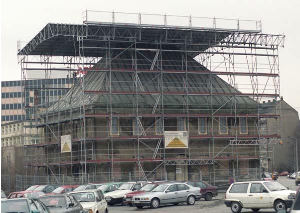
(Schießhaus mit Gerüstdach während der Rekonstruktion /8/ )
