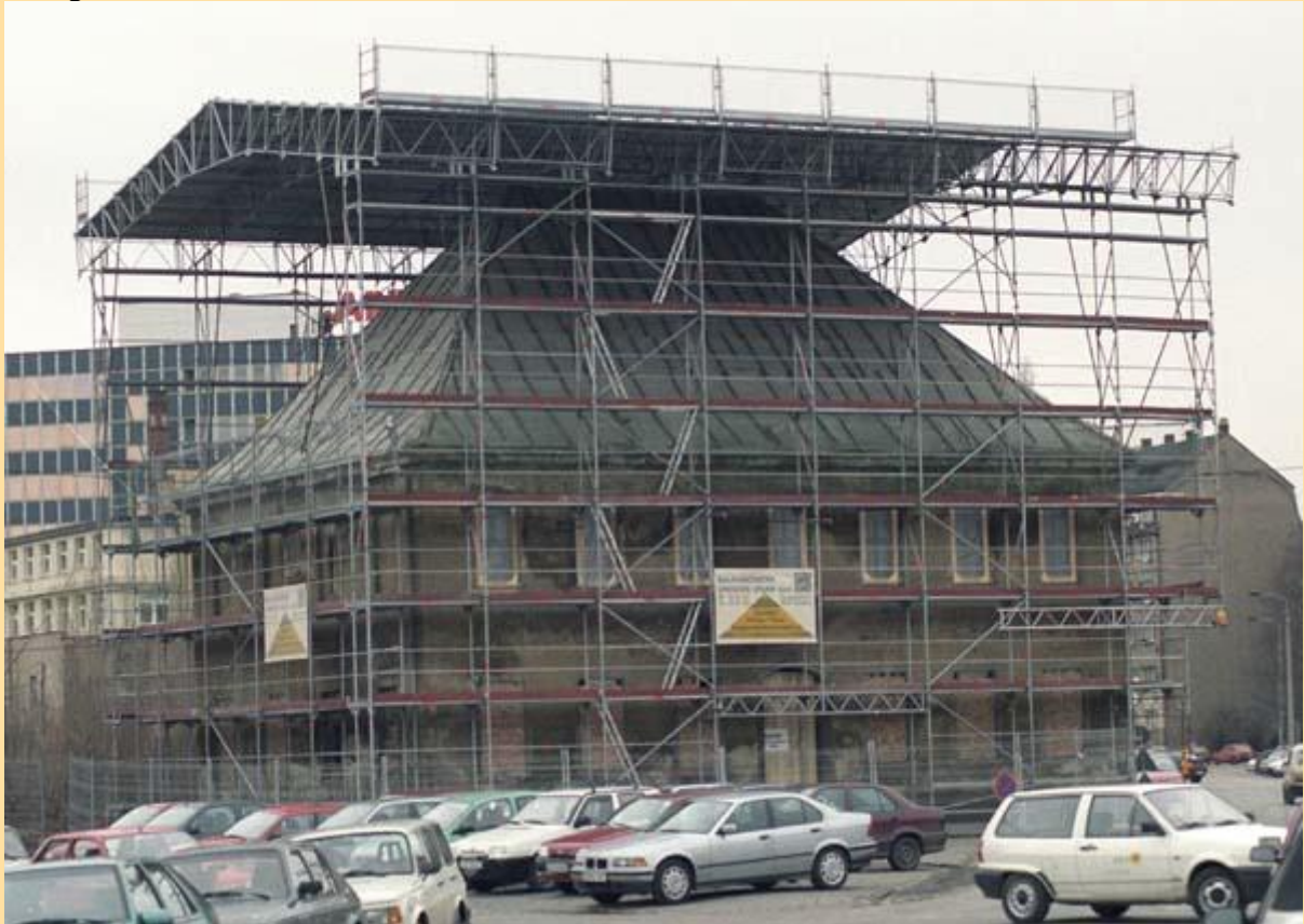
(Schießhaus mit Gerüstdach während der Rekonstruktion /8/ )
