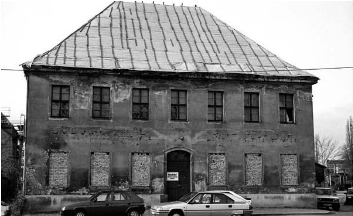
(Schießhaus nach der Notsicherung 1994 /7/ )
